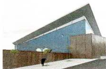
Bodega Valbusenda ubicada en el término municipal de Peleagonzalo Foto Ical
